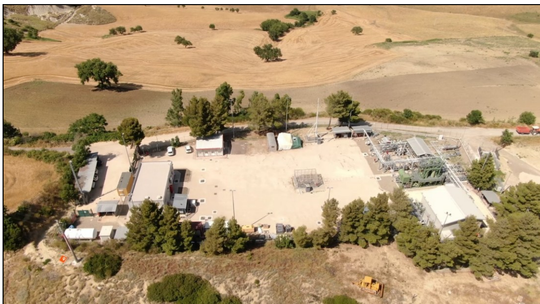
Figura 1 – Vista dall'alto della C.le di Garaguso
